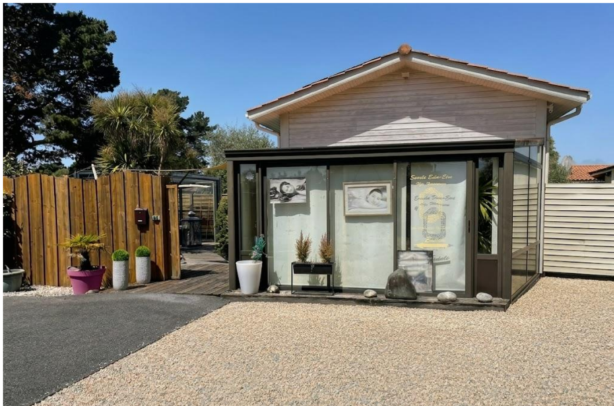
INS01 : L'accès à l'institut et la place de parking PMR.
